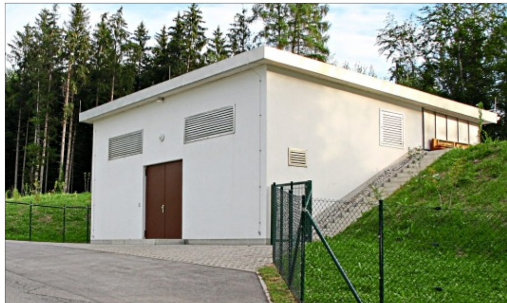
Der neue Hochbehälter befindet sich am Fuße des Ulrichshögl gegenüber der früheren Anlage. – Fotos: Stefanie Weschler
