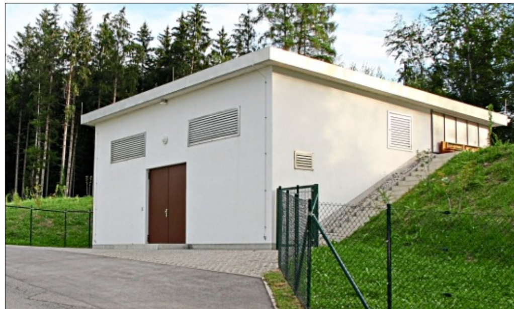
Der neue Hochbehälter befindet sich am Fuße des Ulrichshögl gegenüber der früheren Anlage. – Fotos: Stefanie Weschler
